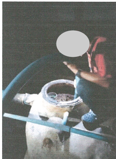
รูปภาพที่ 2.24 การสูบน้ำจากถังเกรอะ
