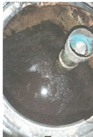
รูปภาพที่ 2.24 การสูบน้ำจากถังเกรอะ
